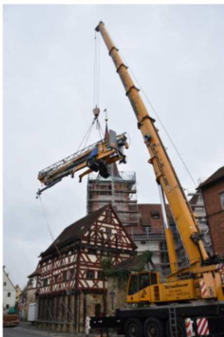
Ein Autokran hieft den Baukran von der Hauptstraße in den Kirchhof. | Foto: M. Gundel
